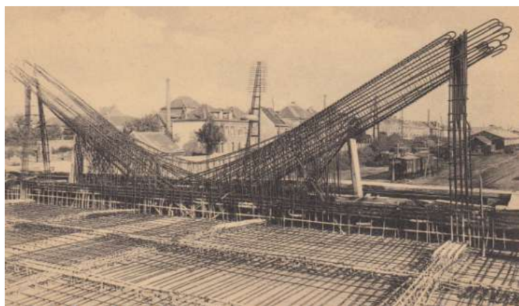
en fil d'acier pour la construction d'un pont de type « bow-string » à Mouscron, non circulée.
