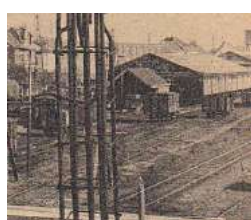
Détail des voies ferrées
